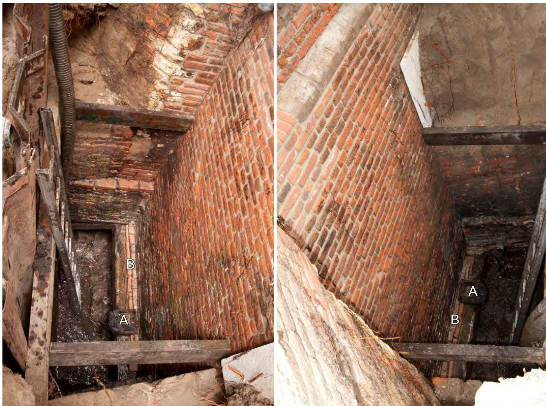
51 Links: De westgevel van de poort (rechts) gezien richting Sint-Lucastoren (boven). Rechts: De westgevel (links) en de stadsmuur (boven) bij het funderingsonderzoek van 2011. Goed zichtbaar is de uitstekende balk van de roosterfundering (WAAG2-1)
