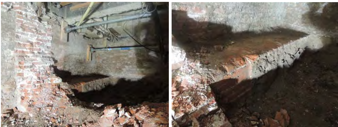
26 Links: de dwarsmuur tussen het midden (links) en westelijke (rechts) compartiment tijdens de sloop. Rechts: uitgemetseld blok van het westelijke compartiment.
