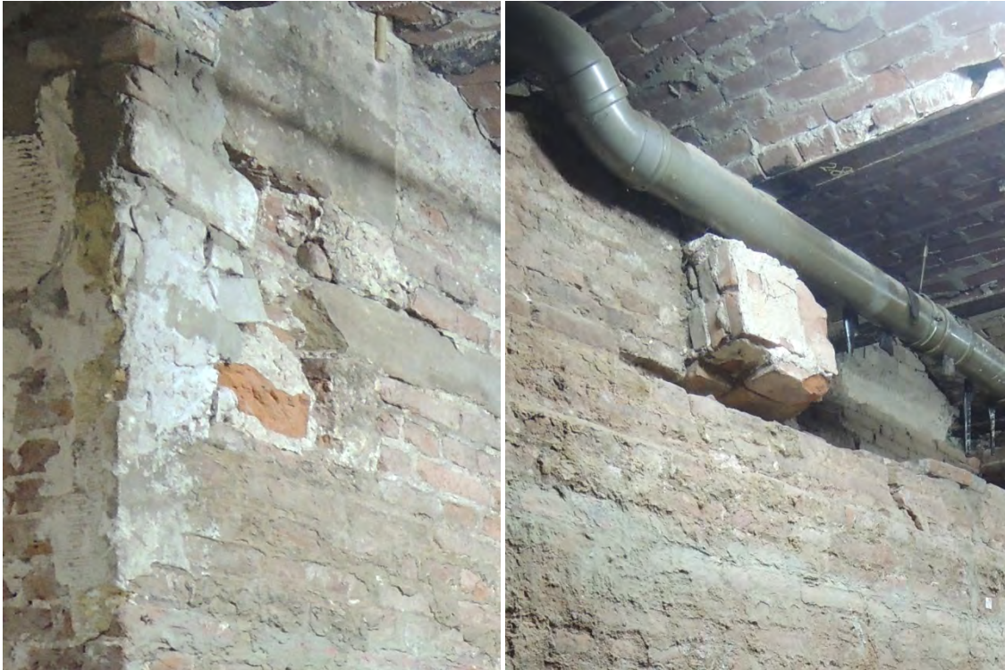
43 Boogaanzetten in de oostelijke zijbeuk
