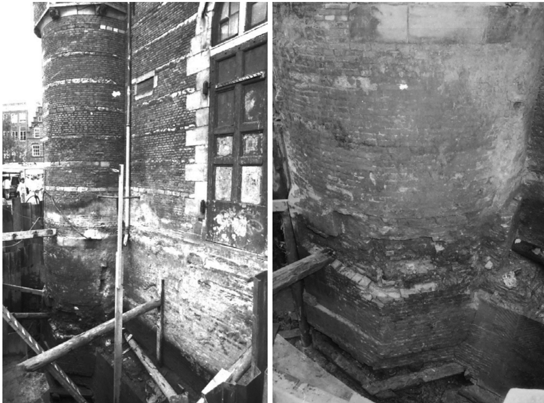
14 Links: Overzichtsfoto van de in 1987 gegraven funderingsput met de Klompensmakerstoren (links) en zuidgevel van de voorpoort (rechts). Rechts: De Klompensmakerstoren met rechts de natuurstenen schil die tegen de zuidgevel was aangebouwd
