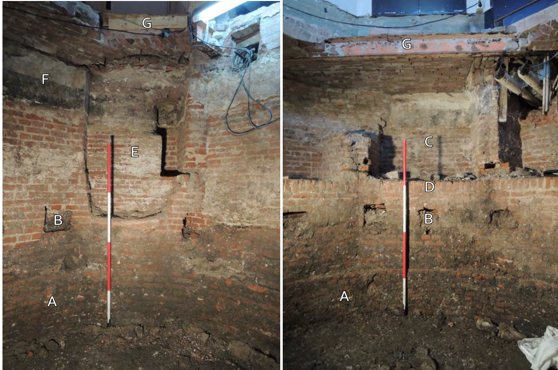
57 Links: Binnenzijde van de Sint-Eloystoren, nis met de latrine. Rechts: Binnenzijde van de Sint-Eloystoren, later uitgehakte balkgaten
