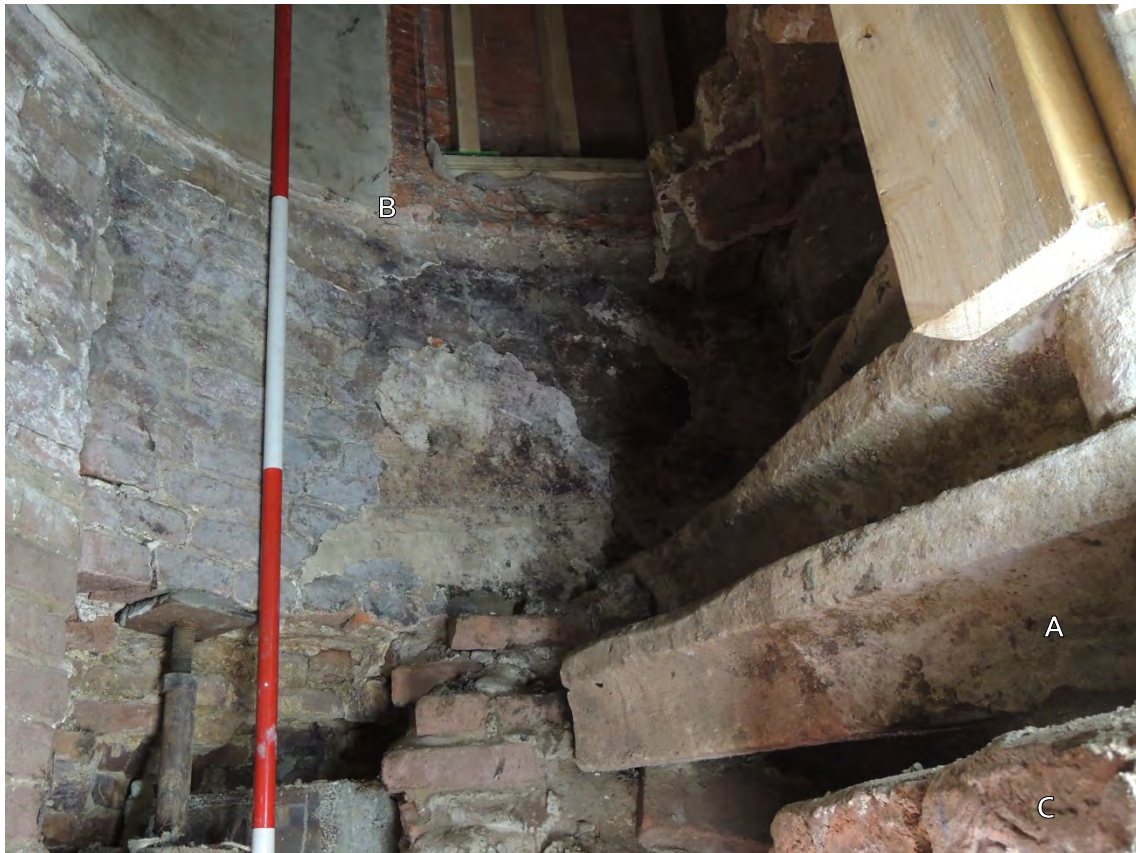
46 Binnenzijde Metselaarstoren, spiltrap met zandstenen treden
