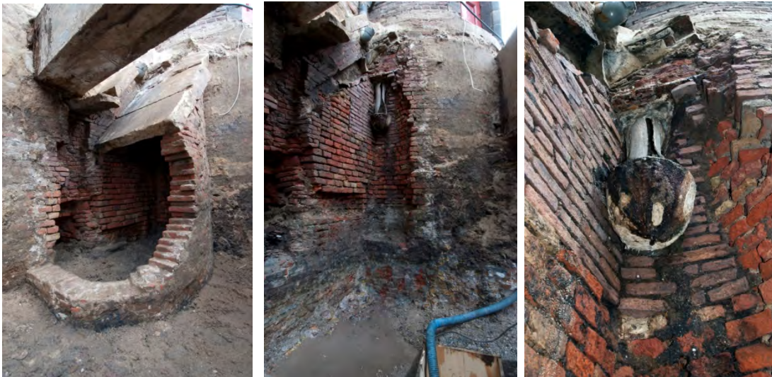
66 Latrine in de hoek van de Theatrum Anatomicumtoren in verschillende fasen van ontmanteling. Links is het gat naar de duiker zichtbaar evenals de natuurstenen glijgoot, midden de positie van de secrettrechter tegen de toren en rechts een detail hiervan
